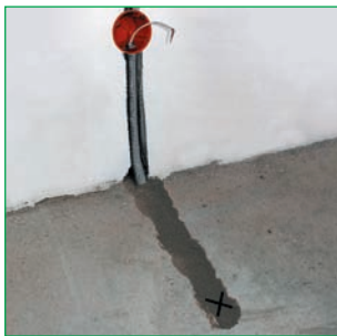
▲ Метка понадобится при укладке кабеля
