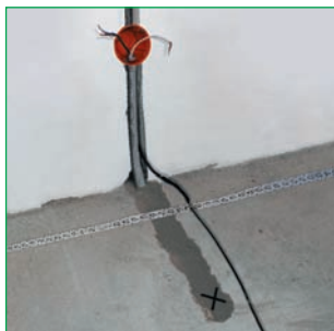
◀ Начало укладки кабеля Весь кабель уложен ▼
