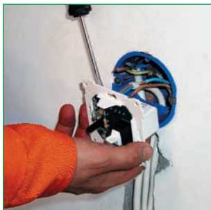
Подключение терморегулятора
