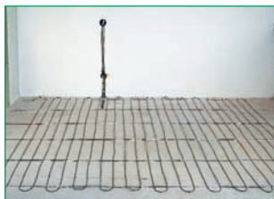
◀ Начало укладки кабеля Весь кабель уложен ▼
