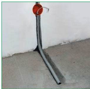
▲ При замене термодатчика не потребуется вскрывать пол
